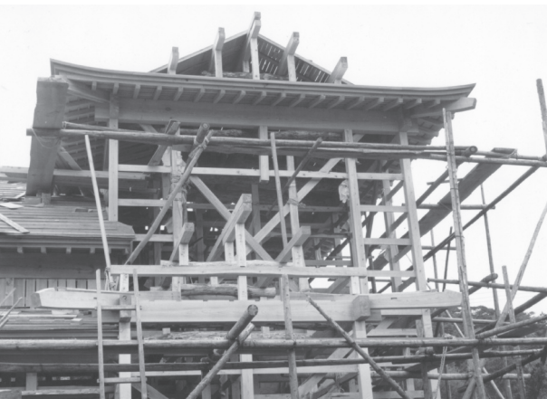
写真2 建築物の骨組
