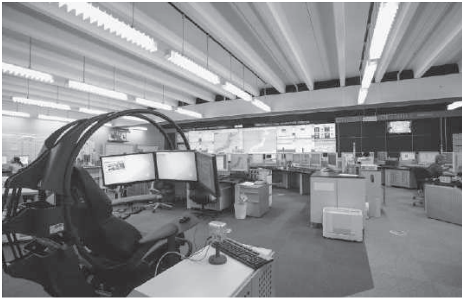
▲全国2カ所にあるNTTファシリティーズのオペレーションセンター。ビルや設備を24時間365日、リアルタイムで監視している。非常時には、需要家への異常情報のお知らせや、事業所に設備・運用情報などを的確に通達し、保守・管理業務をサポートしてくれる。
