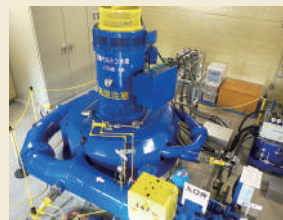
立軸4射ベルトン(チェコ・マーベル社)236 kW
