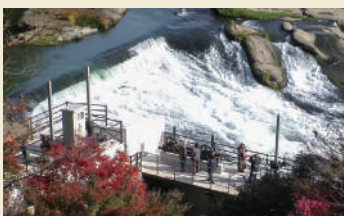
新曾木発電所(490 kW) 鹿児島県伊佐市との共創事業
