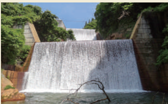
高井発電所(420 kW) 既設の砂防ダムに発電設備を導入
