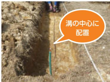
①溝を掘削し接地線を敷設
